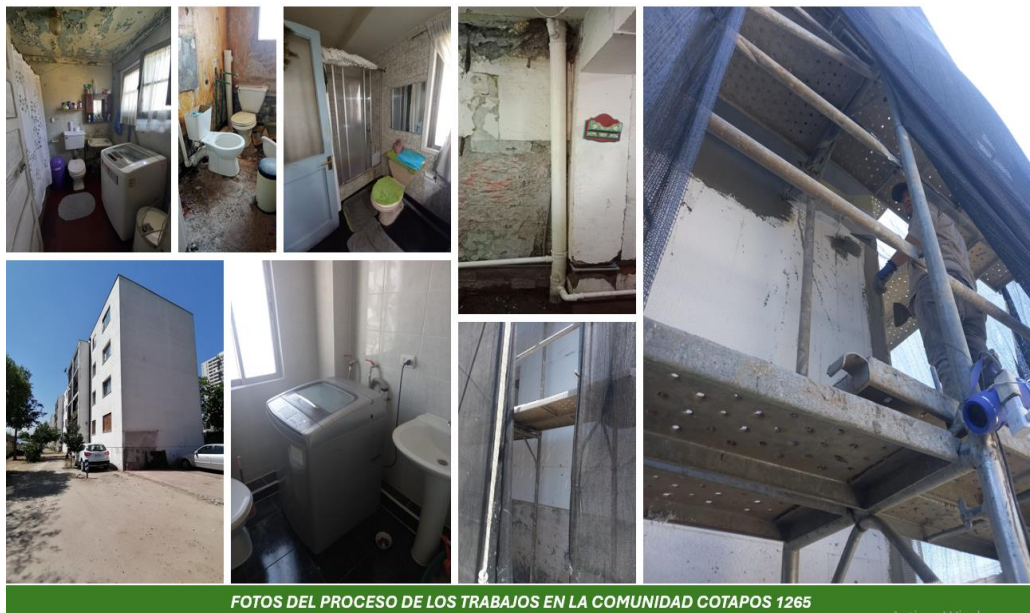
FOTOS DEL PROCESO DE LOS TRABAJOS EN LA COMUNIDAD COTAPOS 1265
