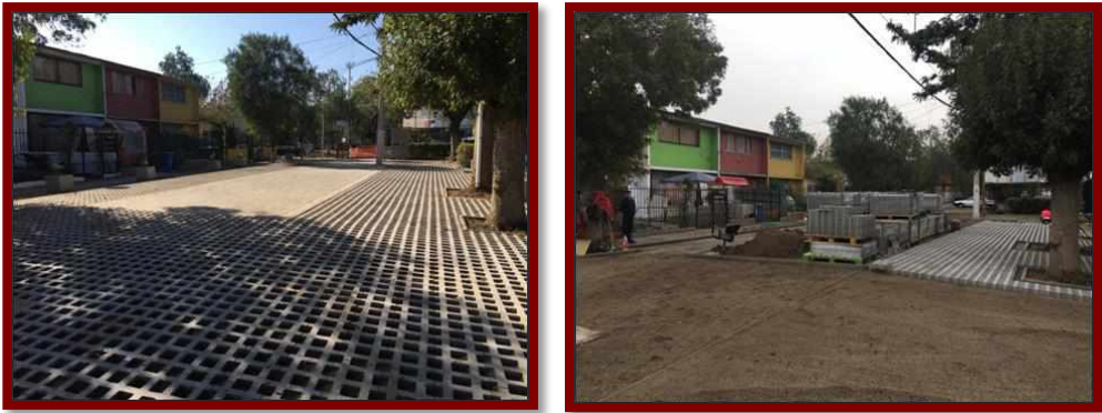
Imagen ejecución Espacio público Soberanía
